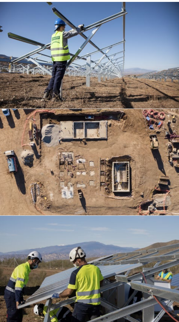
Oben im Bild: Montage der Trägerstruktur der Photovoltaik-Module des Solarparks La Cabrita Mitte: Bau des Umspannwerks Unteres Bild: Montagearbeiten der Module
