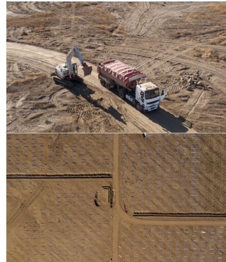
Beginn der Bauarbeiten (September 2020, Bild oben) und der mechanischen Montagearbeiten (Oktober 2020) des Solarparks La Cabrita in Tabernas.
